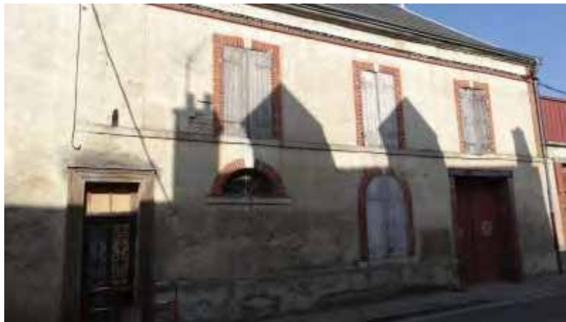
Détail d'un immeuble composé de carreaux de terre crue
