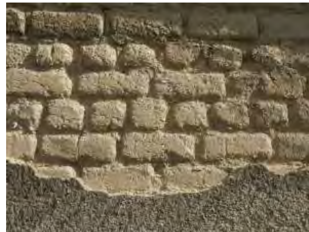
Détail d'un mur en de carreaux de terre crue
