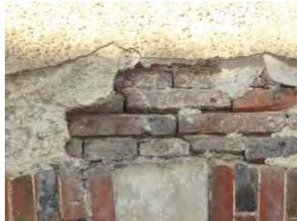
Détail d'un mur en brique
