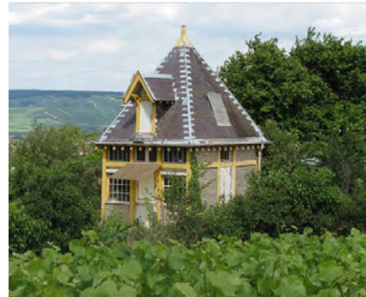
Exemple d'une loge de vignes à Epernay Crédit photo : internet, Panoramio, Philippe BERTHOD.
