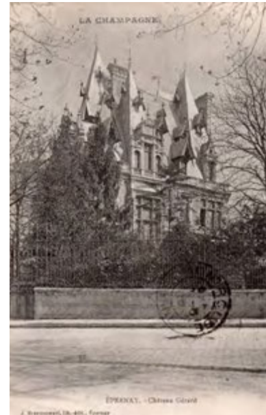
Exemple de l'Hôtel dit Château Gérard, construit dans le 4 ème quart du 19 ème siècle pour le banquier, manufacturier et futur maire Charles Gérard, couvrant 268 m 2 , avec un jardin fermé de grilles, une maison contiguë en location avec cour et jardin. Après l'échec de la construction d'un hôtel de ville sur la place Hugues Plomb, la Ville envisage l'achat de la demeure de Charles Gérard afin de l'affecter à la fonction d'hôtel de ville et confie cette étude en 1896 à l'architecte municipal Dupont. Mais c'est en fait l'hôtel Auban-Moët voisin qui est choisi (acheté par la Ville en 1920). L'hôtel est occupé par un hôpital durant la guerre de 1914-1918. Une réaffectation de l'édifice en un musée de la Guerre est étudiée également en 1920. En avant de cet hôtel, en façade sur la place de la République, subsiste une maison de 104 m 2 d'emprise appartenant à Martin Desaint, qui prive l'hôtel Gérard de son dégagement vers la place. Elle est démolie vers 1920. Le Château Gérard est occupé ultérieurement par une banque. L'édifice est démoli en 1971 pour faire place à une succursale bancaire construite par l'architecte Bernard Minot (permis de construire en 1968).
